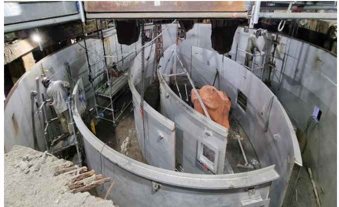
Figura 5. Armado de estructura del Horno
