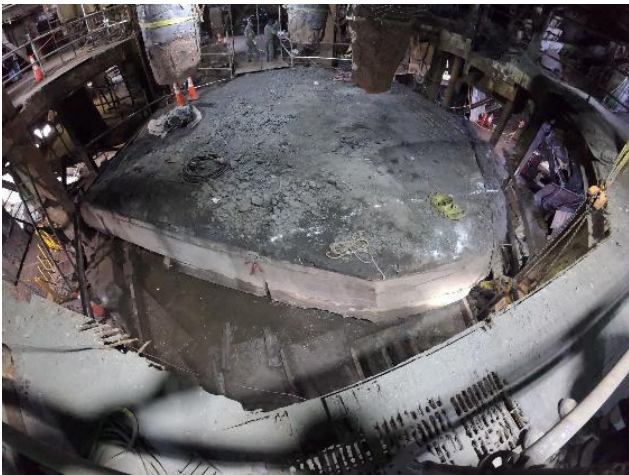
Figura 4. Corte de piso con hilo diamantado
