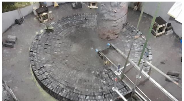
Figura 6. Construcción Refractaria de piso
