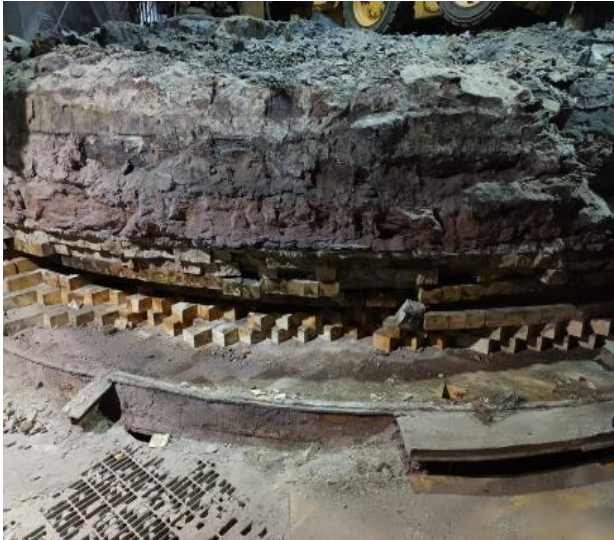
Figura 3. Demolición Refractaria
