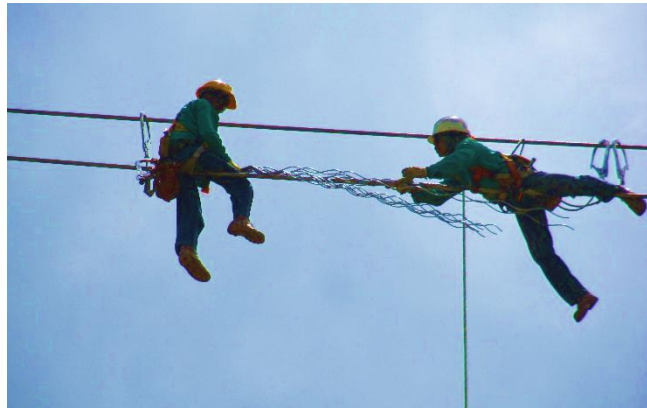
fig. 5 Instalación preformado de reparación
