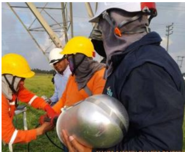
Fig. 4 Instalación caja de empalme OPGW en una torre
