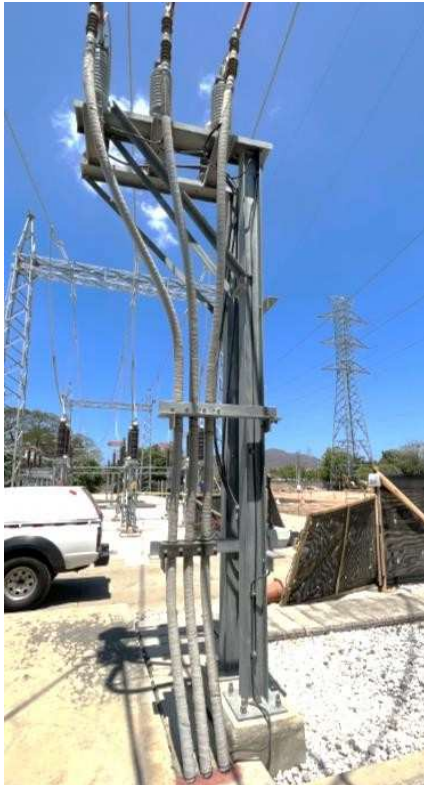
Fig 2. Cable de potencia XLPE con protección en chaqueta exterior
