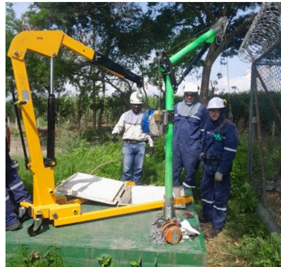
Fig 1. Equipo y personal necesario para acceder a estructura tipo bunker.
