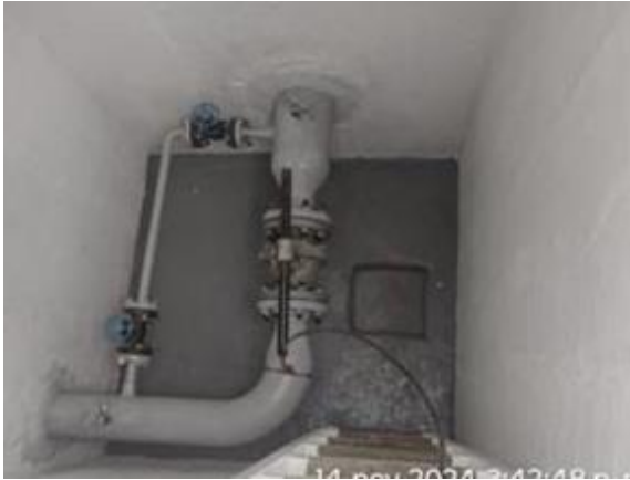
Fig 3. Modelo caja válvula con trabajo en alturas y espacio confinado – vista interior.
