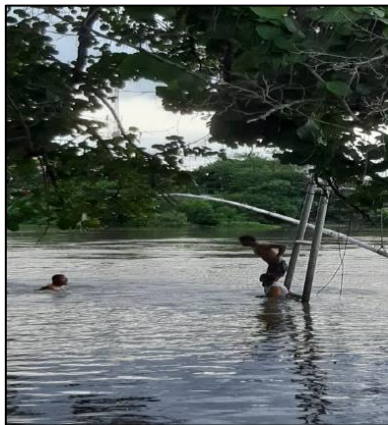
Fig. 1 Cruce Gamarra. Riesgo Público
