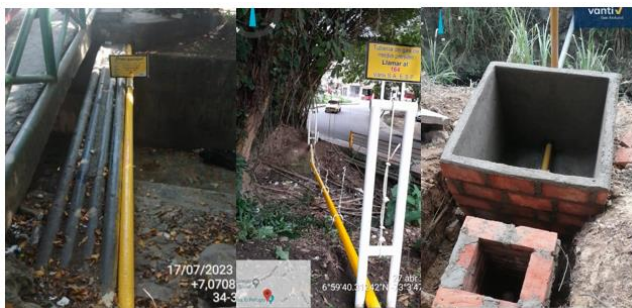
Fig. 14. Acondicionamiento cruces aéreos
