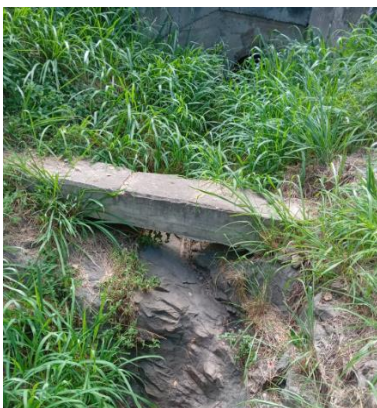
Fig. 6 Cruce recubierto en concreto
