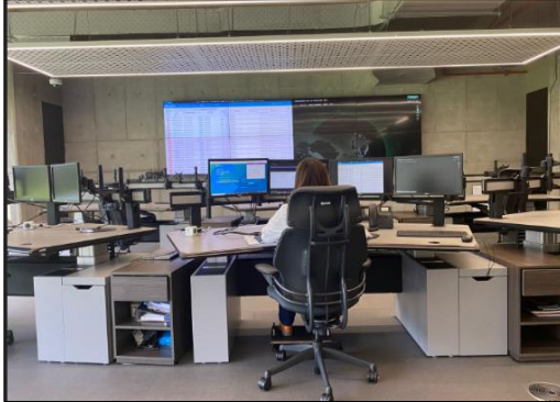
Fig. 8 Centro operaciones ciberseguridad
