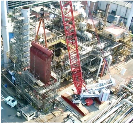
Figura 18. Levantamiento de la carga con grúa de 600 ton.
