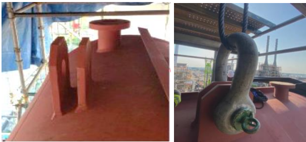
Fig 16. Instalación de cartelas y grilletes.
