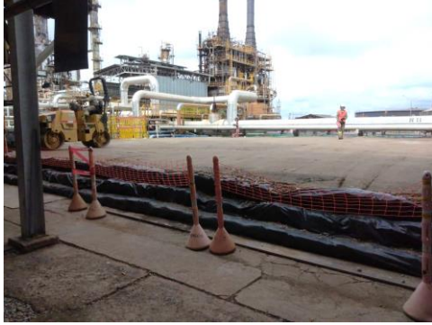
Fig 14. Montaje de terraplen.
