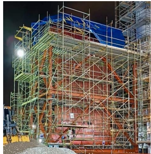
Figura 17. Montaje de banco principal en estructura.
