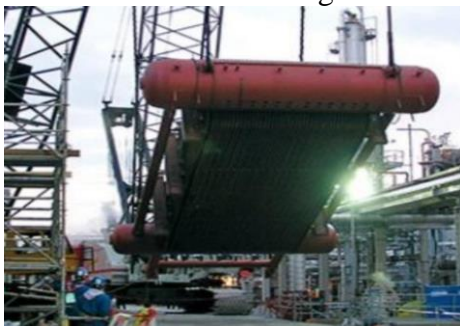
Fig 3. Izaje conjunto banco principal 70 ton. Babcock & Wilcox.
