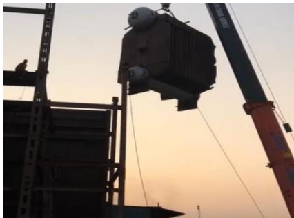
Fig 2. Izaje conjunto banco principal 40 ton. Mago Thermal.
