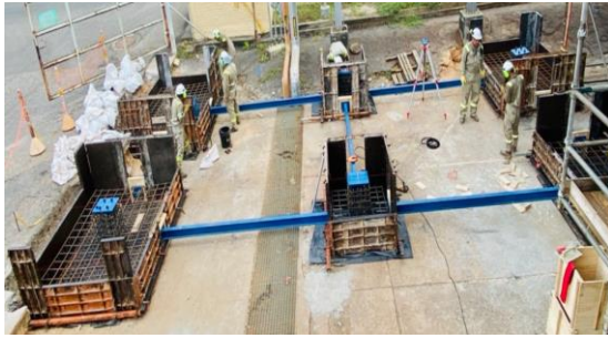
Fig 9. Construcción de bases soporte
