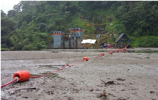
Fig. 2. Embalse CHBA sedimentado
