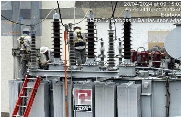
Fig. 10 Intervención de mantenimiento en un Transformador de Potencia.
