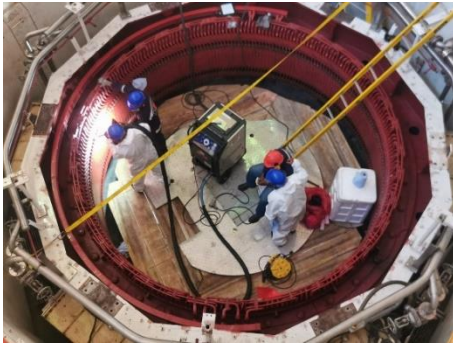
Figura 13. Proceso de reparación de las cabezas de bobina del estator.
