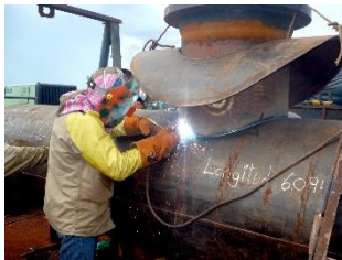
Imagen 2. Instalación de Tap Lícito
