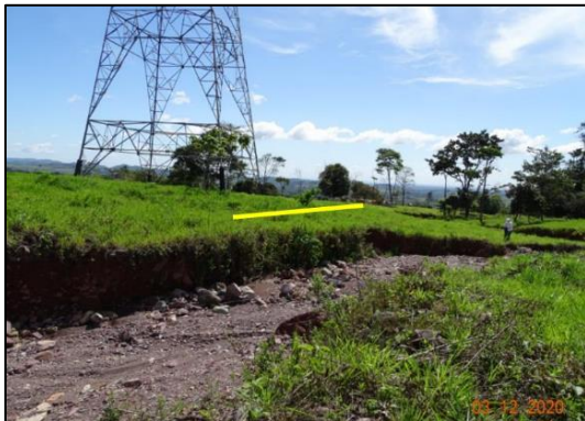
Fig. 8. Torre A – Línea de gaviones Fuente: Propia, 2024
