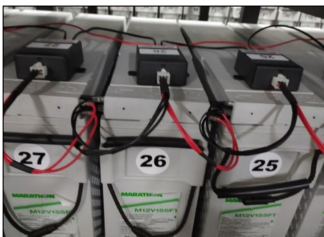
Fig. 3. instalación de sensores en serie.
