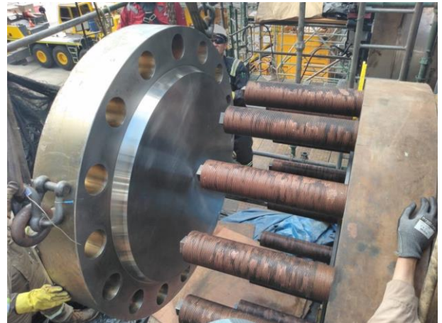
Fig 11. Instalación nueva tapa canal.
