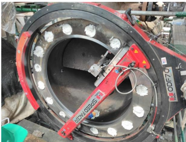
Fig 9. Ejecución mecanizado canal 110-HCU-E-006D.
