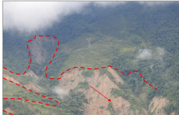
Fig. 15. Deformaciones – Torre H Fuente: Propia, 2022
