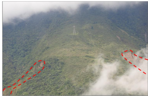
Fig. 16. Deformaciones – Torre I Fuente: Propia, 2022
