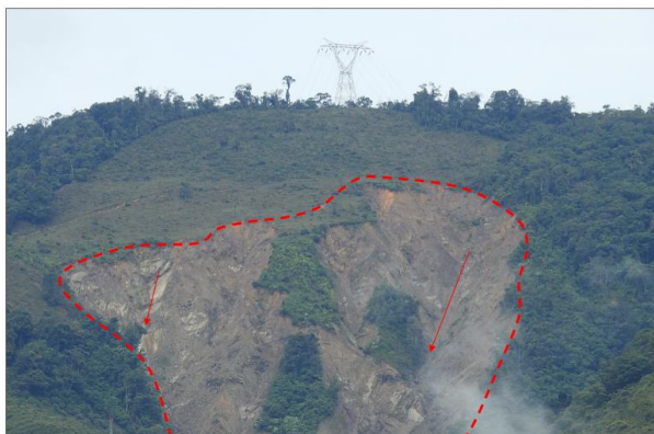
Fig. 14. Deformaciones – Torre G Fuente: Propia, 2022
