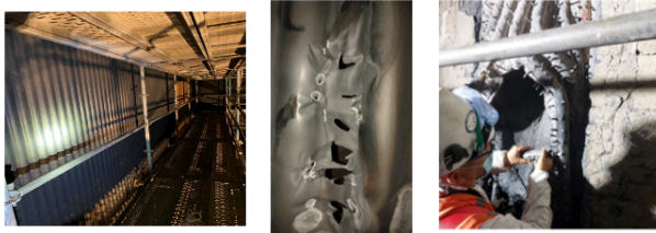
Figura 1: Fotografía de planta generación eléctrica e intervención correctiva tubos interior caldera
