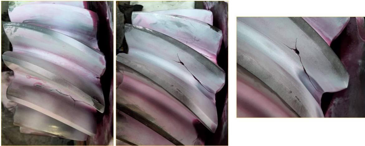
Figura 4 Inspección por tintes penetrantes en piñón observado
